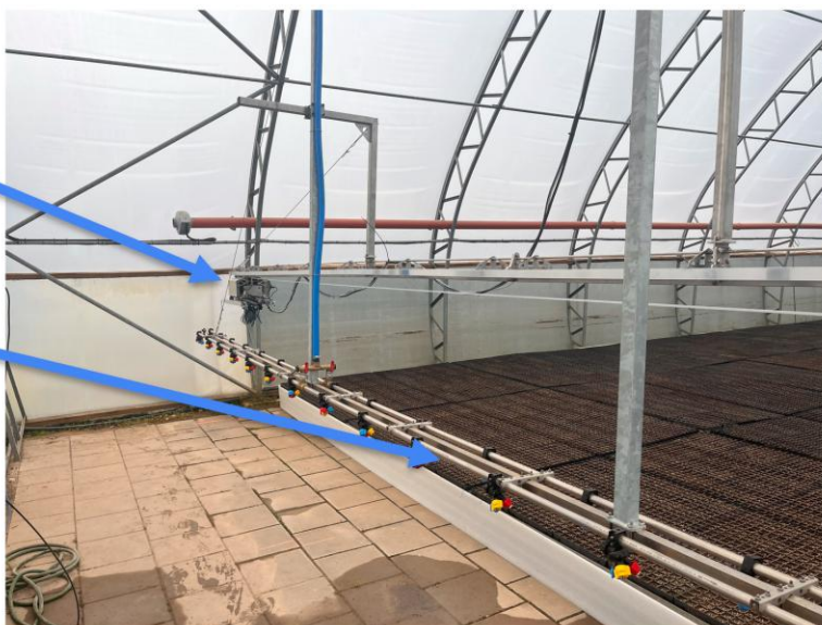
Attēls 16. Sensoru bloks ar gaisa sliedēm integrēts siltumnīcas infrastruktūrā
