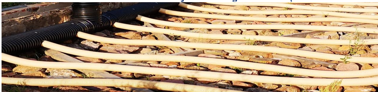
7.2.4. att. Siltumnīcas akumulācijas 100 mm gofrēto cauruļu montāža
