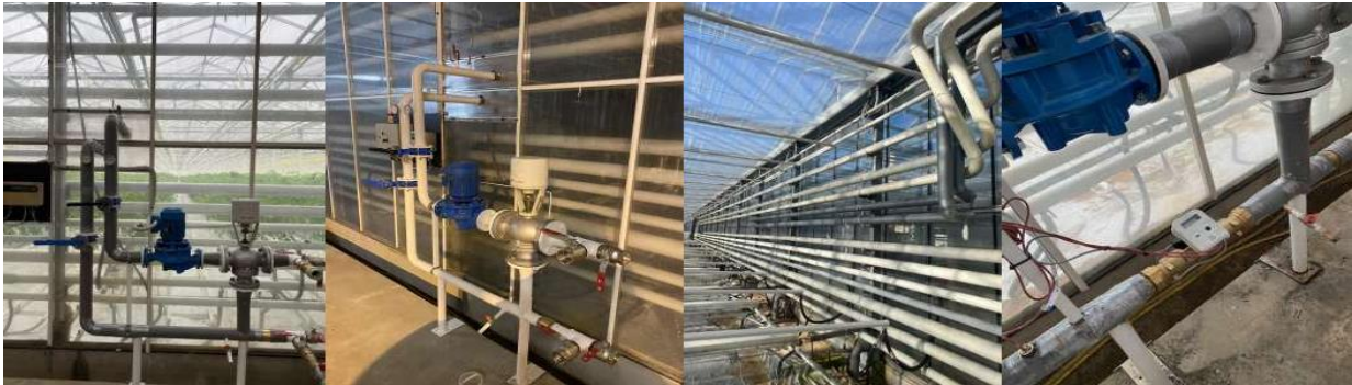
7.8. att. Eksperimentālā siltumnīcas siltummezgla un siltumtrases izbūve
