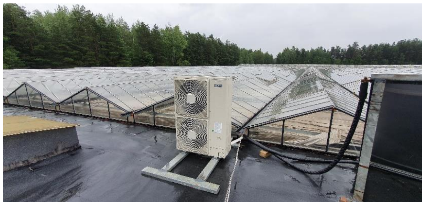
8.2. att. Siltumsūknis 10 kW, SIA Rītausma
