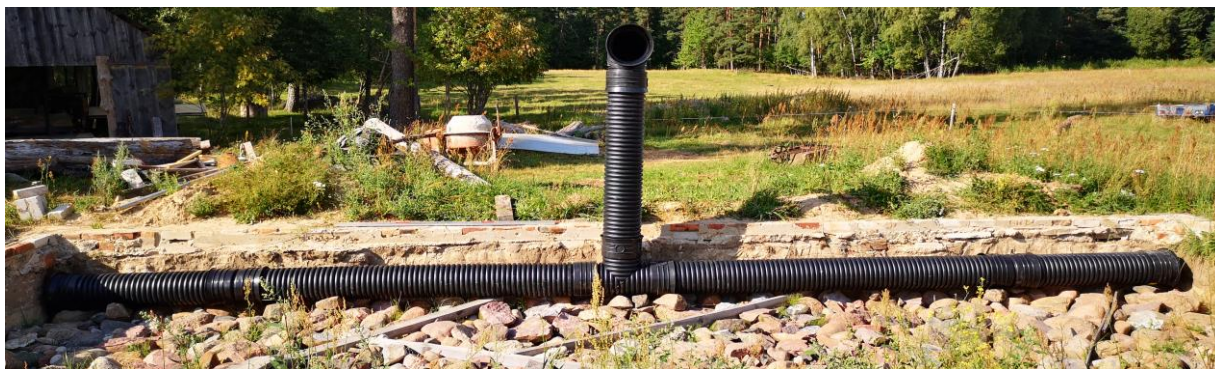
7.2.3. att. Siltumnīcas akumulācijas 300 mm gofrēto cauruļu montāža
