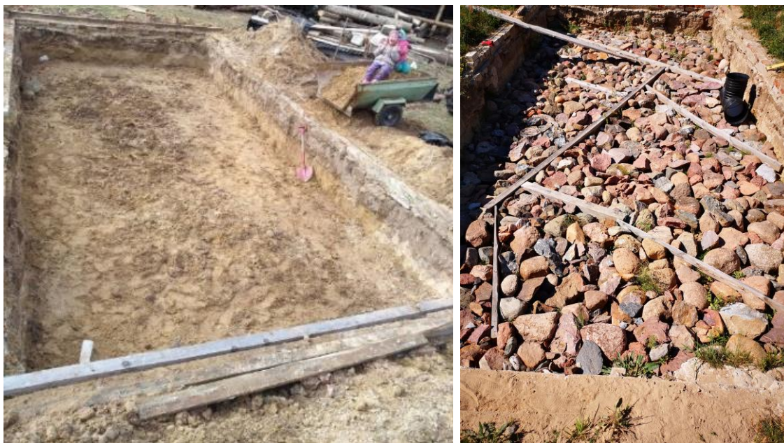
7.2.2. att. Sagatavošanas darbi akumulācijas slāņa izveidei (uz 28.02.2020)
