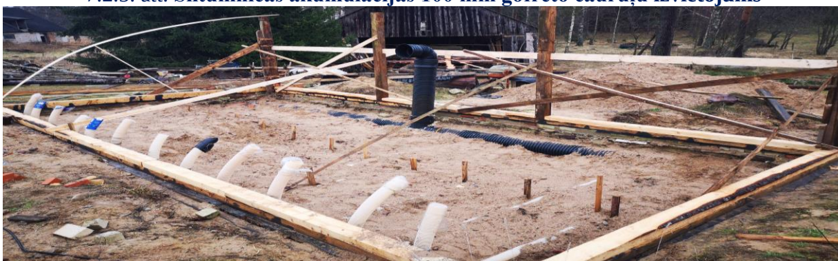
7.2.6. att. Siltumnīcas grants akumulācijas slāņa izveide
