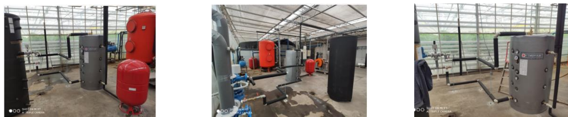
7.8.12. att. Akumulācijas tvertņu pirmā loka (500 litru Tvertne + siltumsūkņis) montāža
