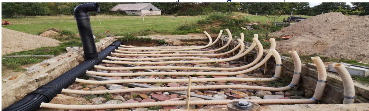
7.2.5. att. Siltumnīcas akumulācijas 100 mm gofrēto cauruļu izvietojums
