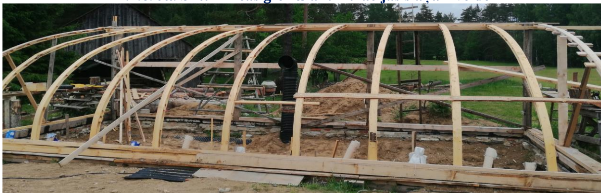
7.2.7. att. Siltumnīcas karkasa montāža
