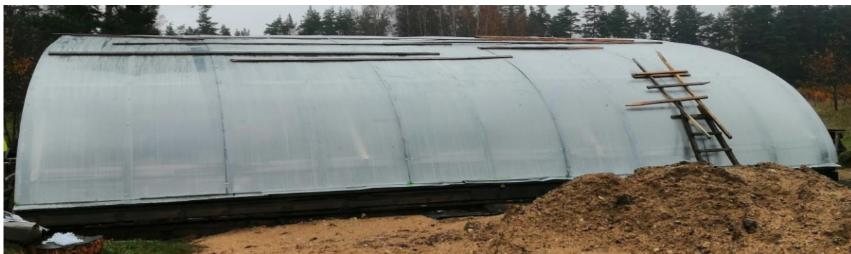
7.2.8. att. Siltumnīcas pārklājuma 6mm polikarbonāta montāža
