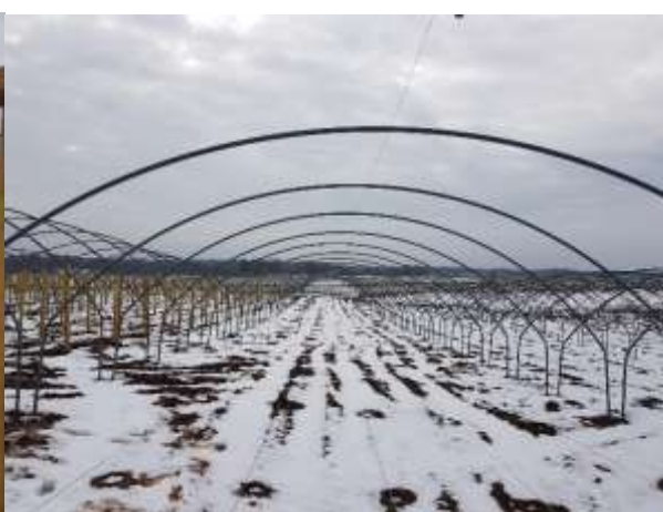
b) Zemeņu siltumnīca
