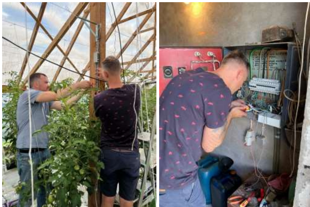
5.14. attēls. Sensoru pievienošana barošanai un esošajam interneta tīklam
