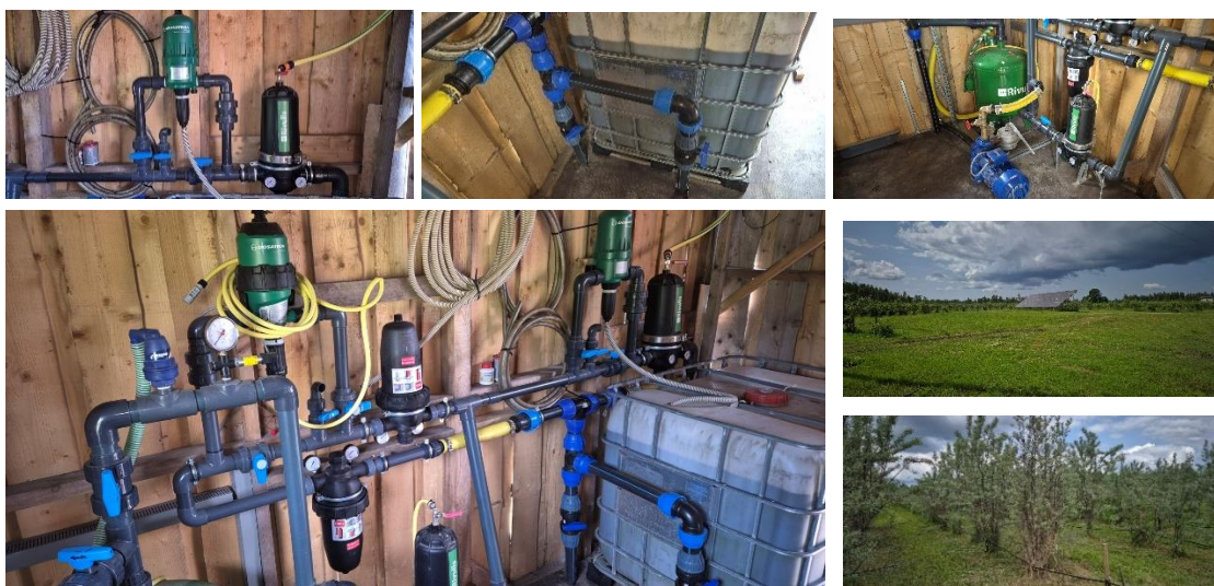
3.4.attēls. Smiltsērķšķu laistīšanas sistēmas ūdens apgādes daļa.
