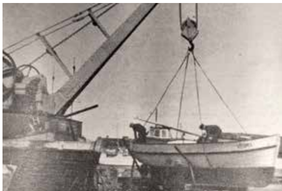
Motorlaivas nolaišana ūdenī ar ceļamkrāna palīdzību Liepājas zvejas ostā
