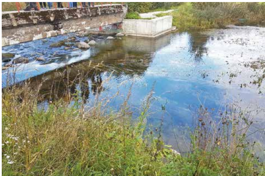
4. attēls. Kompromiss Tapas pilsētā Igaunijā, – ir daļēji saglabāts uz Valgejogi upes izveidots uzpludinājums, taču aizsprosta vietā tā līmeni uztur mākslīgi veidota krāce. Foto: J. Bajinskis
