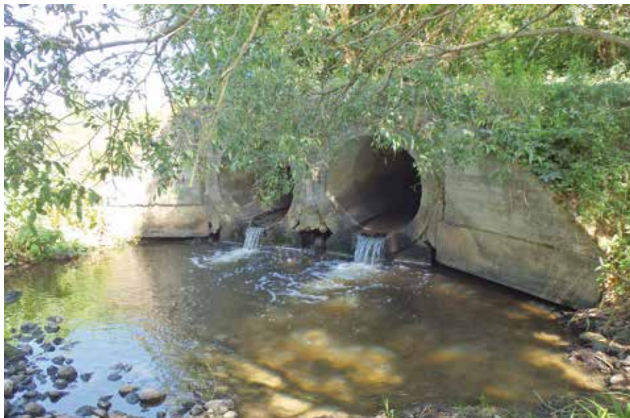
1. attēls. Preiļupe. Arī šāda caurteka ir būtisks šķērslis zivju migrācijai. Foto: K. Abersons
