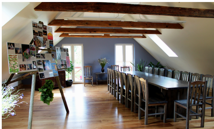
Jūrkalnes pagasta ēkas „Krasti” otrā stāva rekonstrukcija
