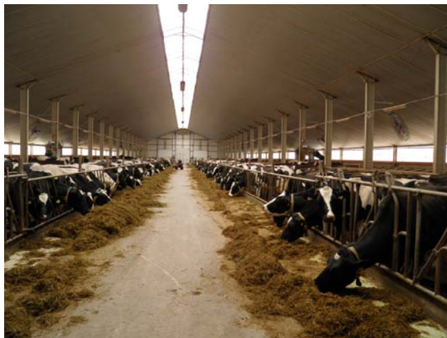
4.attēls Ventilatoru izvietojums slaucamo govju novietnē
