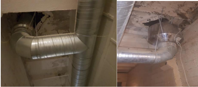
2.att. Pārbūvētā ventilācijas sistēma (R. Neimaņa foto)
